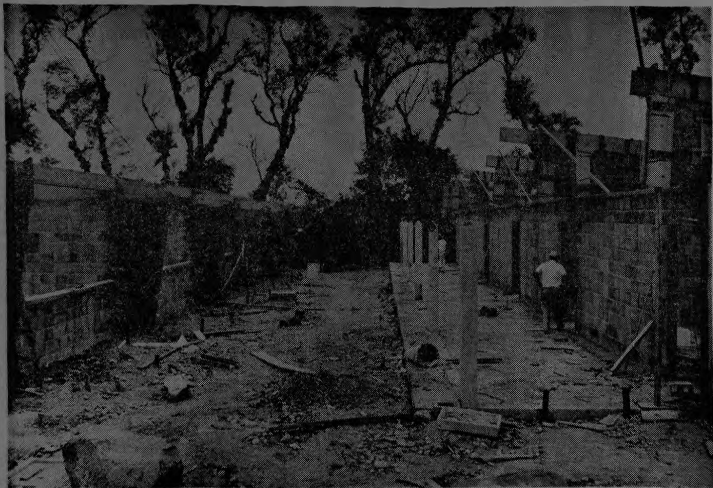
En esta gráfica se da una idea general del estado en que se encuentra la nueva construcción (seis pabellones con cinco aulas cada uno, corredores, pasos cubiertos y campos reservados).
